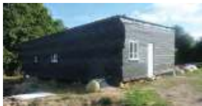
Maison en construction (sep 2016)
