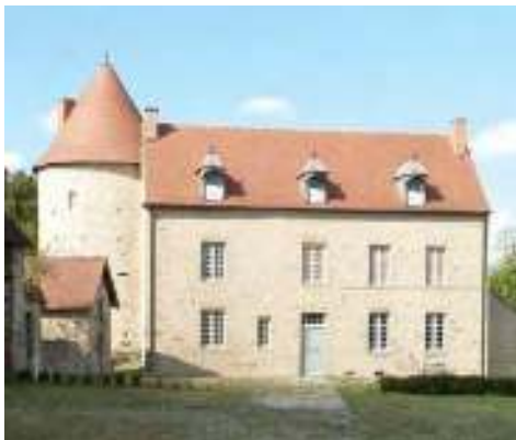
Relai de poste
