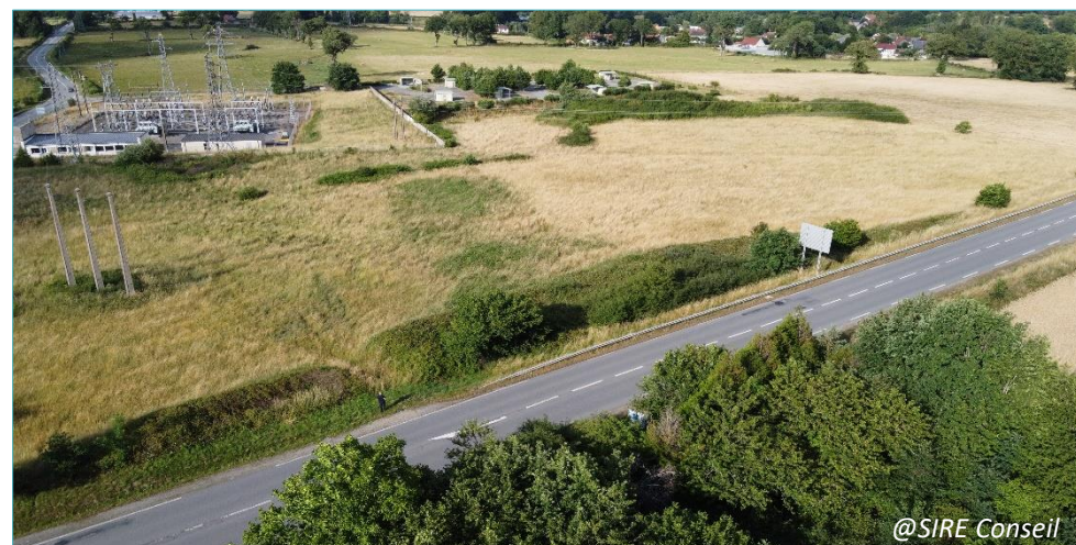
Vue de drone sur la partie Nord du secteur et sur la RD100
